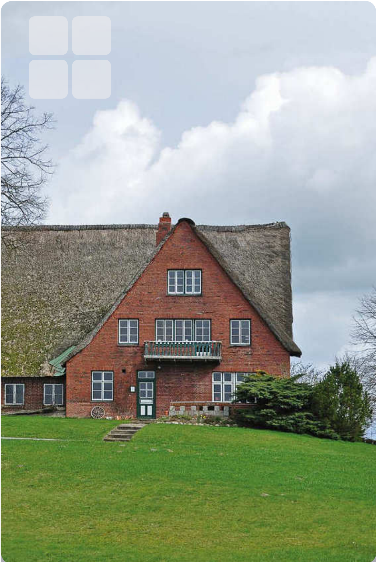
Kleinkläranlagen in ländlichen Gegenden
