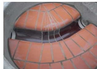
Steinzeug-Gerinne, Kanalklinker-Berme
