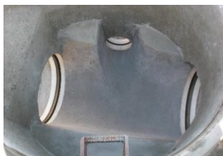
Beton- Gerinne, Beton- Berme
